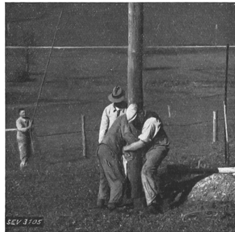
Fig. 3. Der Mast wird auf die Seite geschoben.
