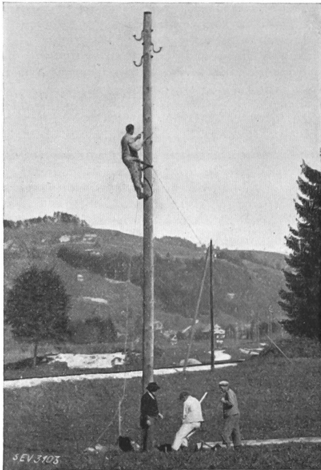
Fig. 1. Das Ankerseil wird am Mast und nachher an zwei links und rechts von der Leitung in den Boden eingetriebenen Ankern befestigt.
