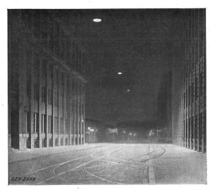
Fig. 2. Mit Natriumdampflampen beleuchtete Strasse in Berlin. (September 1931.)
