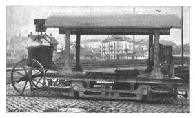
Fig. 1. Elektrischer Asphaltkochwagen der Städtischen Strassenbahn Zürich.
