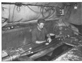
Fig. 17. Wickeln der Muffen. Links und rechts am Kabel sind die bleiernen Abschlusskappen zu sehen.
