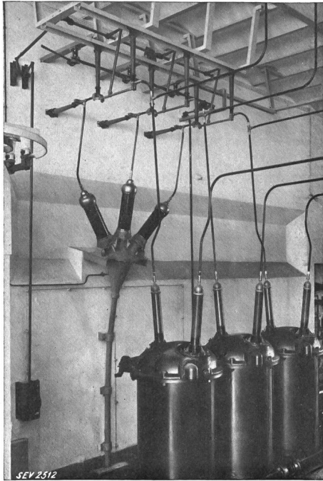
Fig. 19. Kabelendverschluss im Unterwerk Drahtzug.
