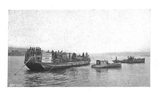
Fig. 12. Verlegen der Kabel im See. Links das 50-kV-Kabel, rechts das Telephon-, Signal und Fernmesskabel.
