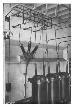
Fig. 19. Kabelendverschluss im Unterwerk Drahtzug.
