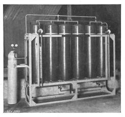
Fig. 20. Expansionsgefässe im Unterwerk Drahtzug, links die Heliumflasche.
