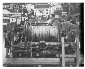
Fig. 10. Umwickeln der See-Kabellänge vom Eisenbahnwagen auf das Verlegungsschiff.
