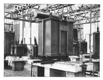
Fig. 9.  $$350\text{-BkVA-Kondensator,} $1\sim16^2/_3$  16 kV, für Bahnanlage.
