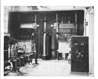
Fig. 13. Prüfanlage, 120 kV Gleichstrom.
