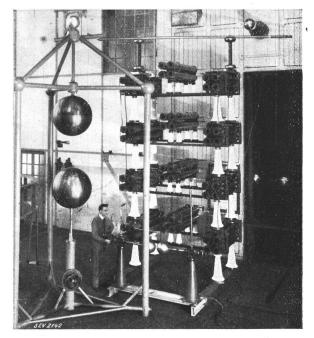
Fig. 1. Générateur d'impulsion à 4 étages.
