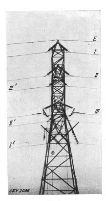
Fig. 6. Probeausführung der neuen Halbabspannung bei Stromleiter III, Mast S, eingebaut. Links nach Mast R, rechts nach Mast T.
