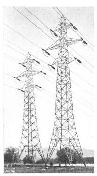
Fig. 10. Rheinkreuzung bei Kraftwerk Ryburg-Schwörstadt. 150 kV mit Zweimantel-Motorisolatoren.
