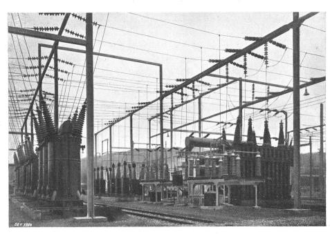
Fig. 13. 150 kV-Freiluftanlage des Kraftwerkes Ryburg-Schwörstadt mit Zweimantel-Motorisolatoren.
