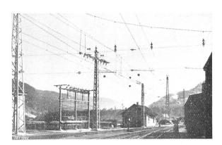
Fig. 11. Fahrleitungen der Oesterreichischen Bundesbahnen 15 kV mit Einmantel- und Zweimantel-Motorisolatoren.
