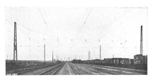
Fig. 12. Fahrleitungen der Deutschen Reichsbahn 15 kV mit Motor-Stabisolatoren.
