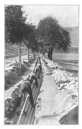
Fig. 4. Einziehen der Kabel.
