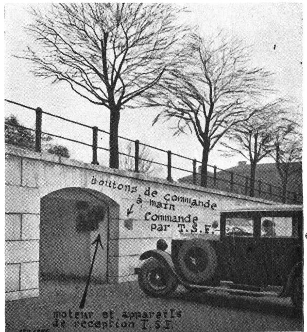
côté de la porte, cette niche est ensuite fermée à clef ainsi que le volet lui-même. Cette fermeture à clef a en outre pour effet de couper automatiquement tous les courants électriques à l'intérieur du garage. En cas de manque de courant électrique, le volet peut également s'ouvrir à la main au moyen du dispositif prévu à cet effet.
