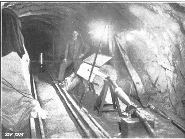
Fig. 21. Herstellung der Verbindungsmuffen.
