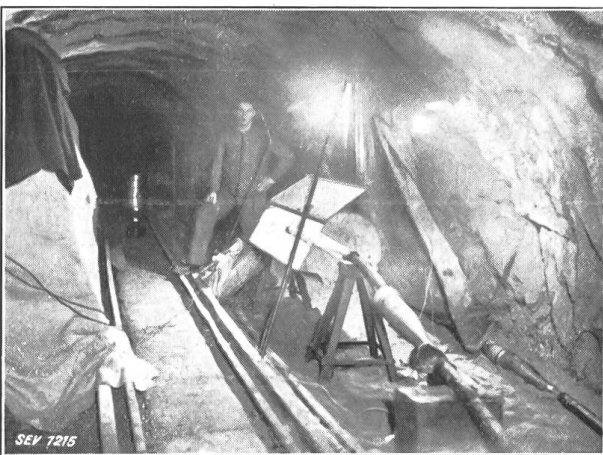
Fig. 21. Herstellung der Verbindungsmuffen.
