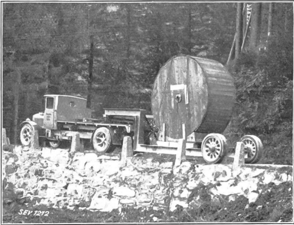
Fig. 19. Transport der Kabel auf der Grimselstrasse.
