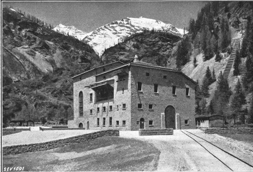
Fig. 3. Kraftwerk Cavaglia. Rechts Druckleitungsgalerie. Gebäude Rückseite. Abgehende 140 kV- und 55 kV-Leitungen.
