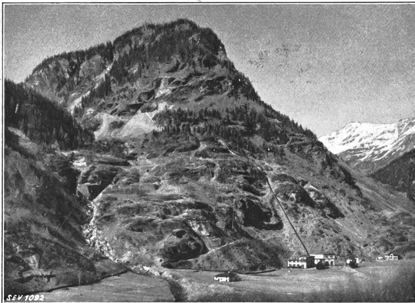
Fig. 4. Kraftwerk Robbia. Gesamtansicht.
