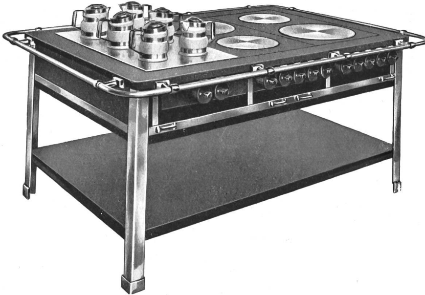
Fig. 1. Hotelherd mit 4 runden Platten, Bain-Marie mit eingesetzten Kaffeekrügen.
