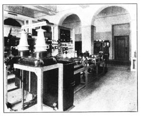
Fig. 6. Aus der 5. Abteilung: Apparate für Hochspannung. Oelschalter.
