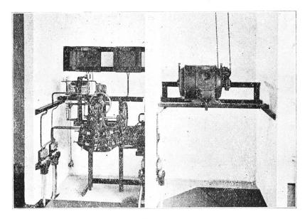
Fig. 24. Régulateur de cos ç ag ssant sur le régulateur d'induction.
