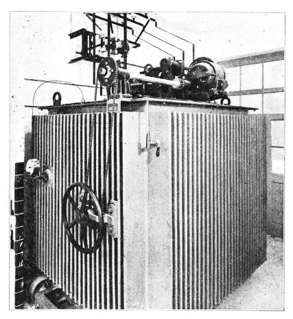
Fig. 23. Régulateur d'induction, 2000 kVA.
