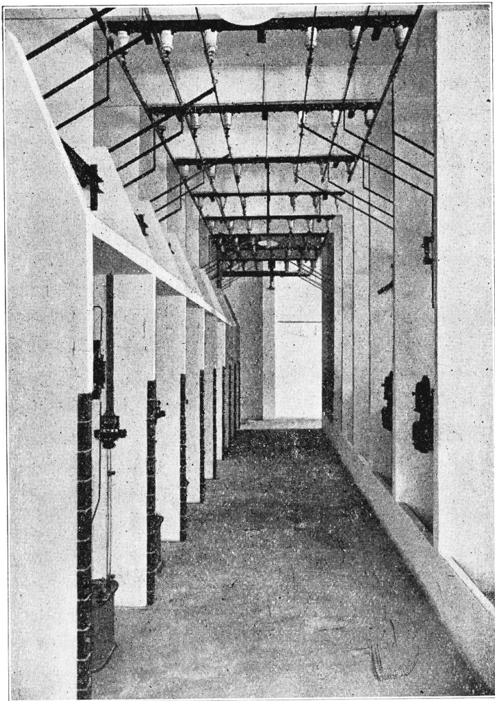
Fig. 22. Barres collectrices à 5600 volts.
