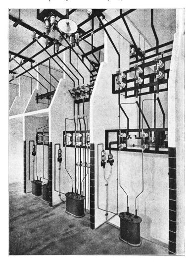
Fig. 26. Partie de l'appareillage à 5600 volts.
