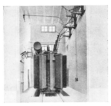
${\rm Fig.~28.}$  Transformateur de 5000 kVA, 5600/60000 — 120000 volts.
