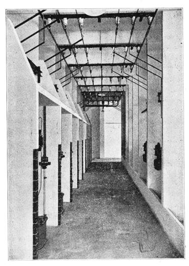
Fig. 22. Barres collectrices à 5600 volts.
