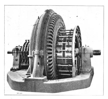
Fig. 11. Commutatrice de 4200 kW.
