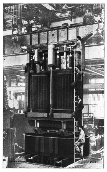
Fig.~18. Transformateur à triple tension, pour 15/66/132~kV.
