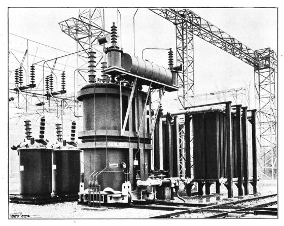
Fig. 19. Transformateur en plein air, avec réfrigérant.
