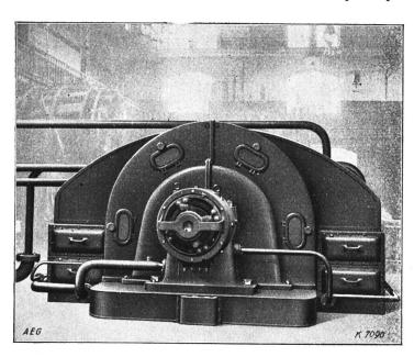
Fig. 3. Alternateur avec réfrigérant fixé latéralement.
