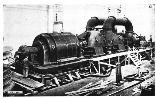
${\rm Fig.~33.}$  Die für Versuche verwendete  $40\,000~{\rm kVA-Turbogruppe}$  am Prüfstand.
