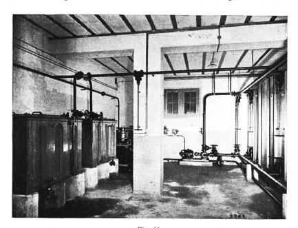
Fig. 11. Oelkeller mit Schmutzölgefässen und Oelschleuder.
