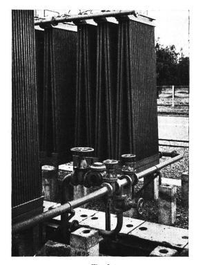
Fig. 9. Ansicht einer Kühlgruppe mit Oelabflussleitungen und Oelströmungsmesser.
