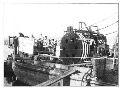
Fig. 6. Kabelverlegungsmaschine.
