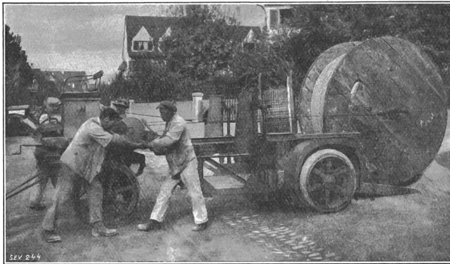
Fig. 12. Kabeltransport- und Verlegungswagen des EWZ beim Beladen auf der Baustelle. (Wytikonstrasse, 14. Oktober 1926).
