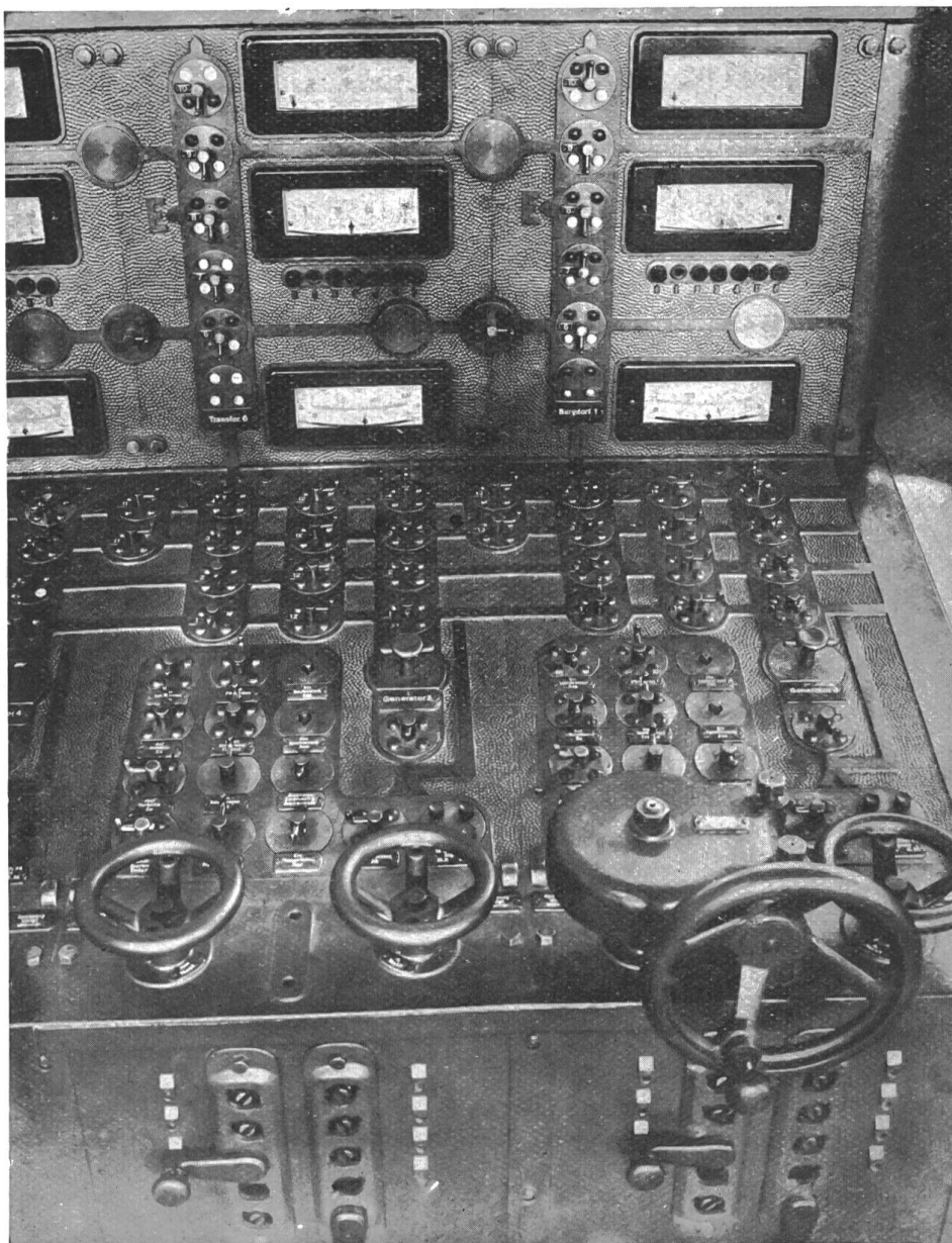
Fig. 31. Schaltbühne: Blick auf das Generatorenschaltpult.
