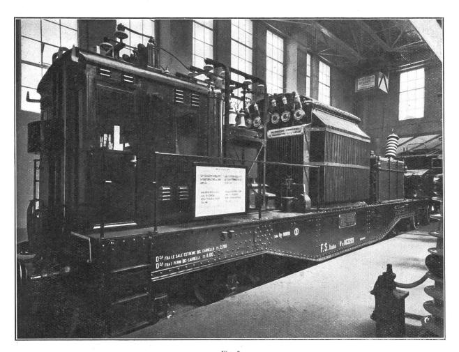
Fig. 3. Fahrbares Unterwerk der Italienischen Staatsbahnen.
