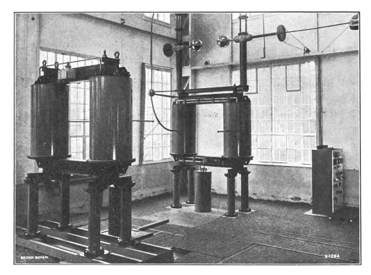
Prüftransformatoren für 1500000 Volt.
