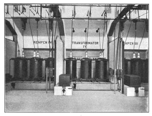
Fig. 1. 50 kV-Schaltergruppen im Kraftwerk Siebnen.
