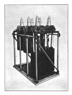
Fig. 22. 19 kV-Oelschalter
