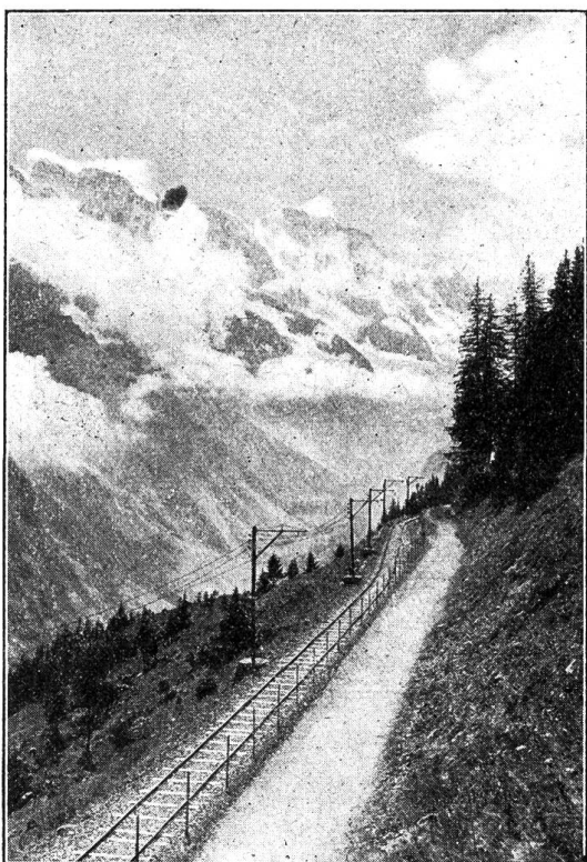
Abb. 5. Vom Schönheitsstandpunkte aus wäre die umgekehrte Anordnung: zu innerst die Träger, dann das Geleise und zu äusserst der Fussweg besser gewesen.
