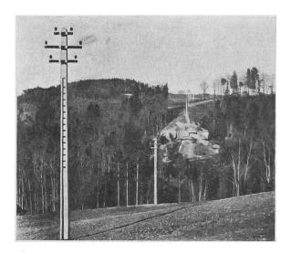
Fig. 9. Ligne 32 000 volts sur mât en béton Houterive-Romont.
