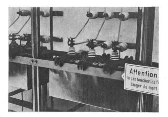
Fig. 1. Usine d'Hauterive. Transformateur d'intensité shunté. 1904.
