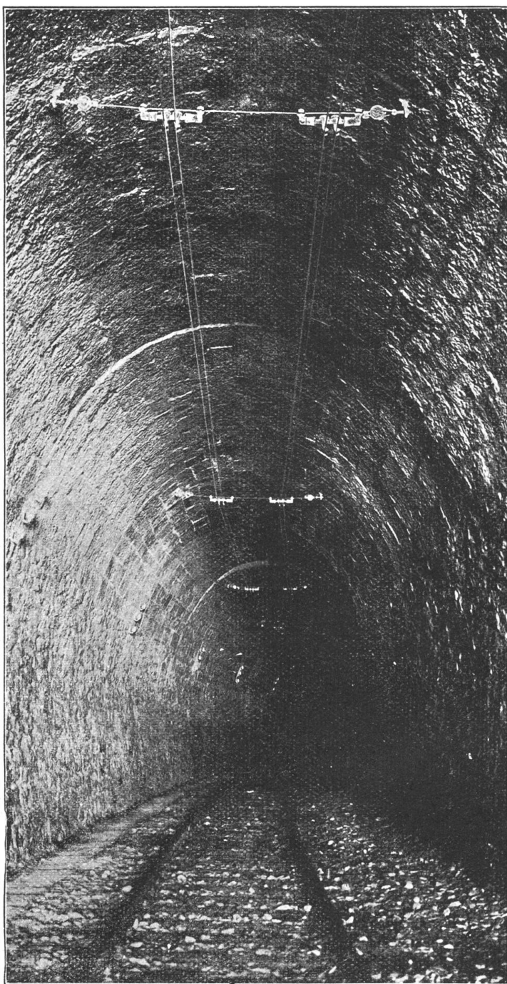
Abb. 14. Anordnung der Kontaktleitung im Tunnel.
