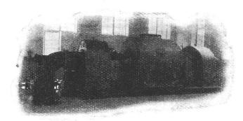
Abb. 1. Turbogenerator mit Wasserturbinenantrieb in Iselle.
