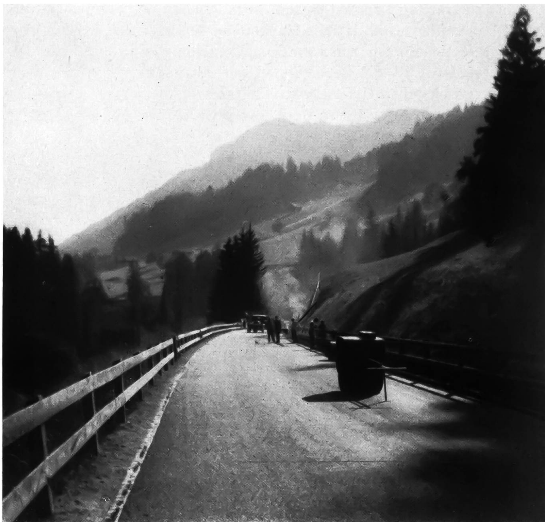
Lehm-Mannried im Simmental - Alphastic-Rauhbelag (Colas AG.) Ausgeführt von der Strassenbauunternehmung M.F. Roth, Bern
