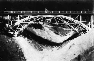
Laxgrabenbrücke (Oberwallis), Erbaut 1942 Gerüst System Coray, Spannweite 45 m. Fertige Betonbrücke Projekt A. Sarasin, Lausanne, Betonarbeiten Walo Bertschinger
