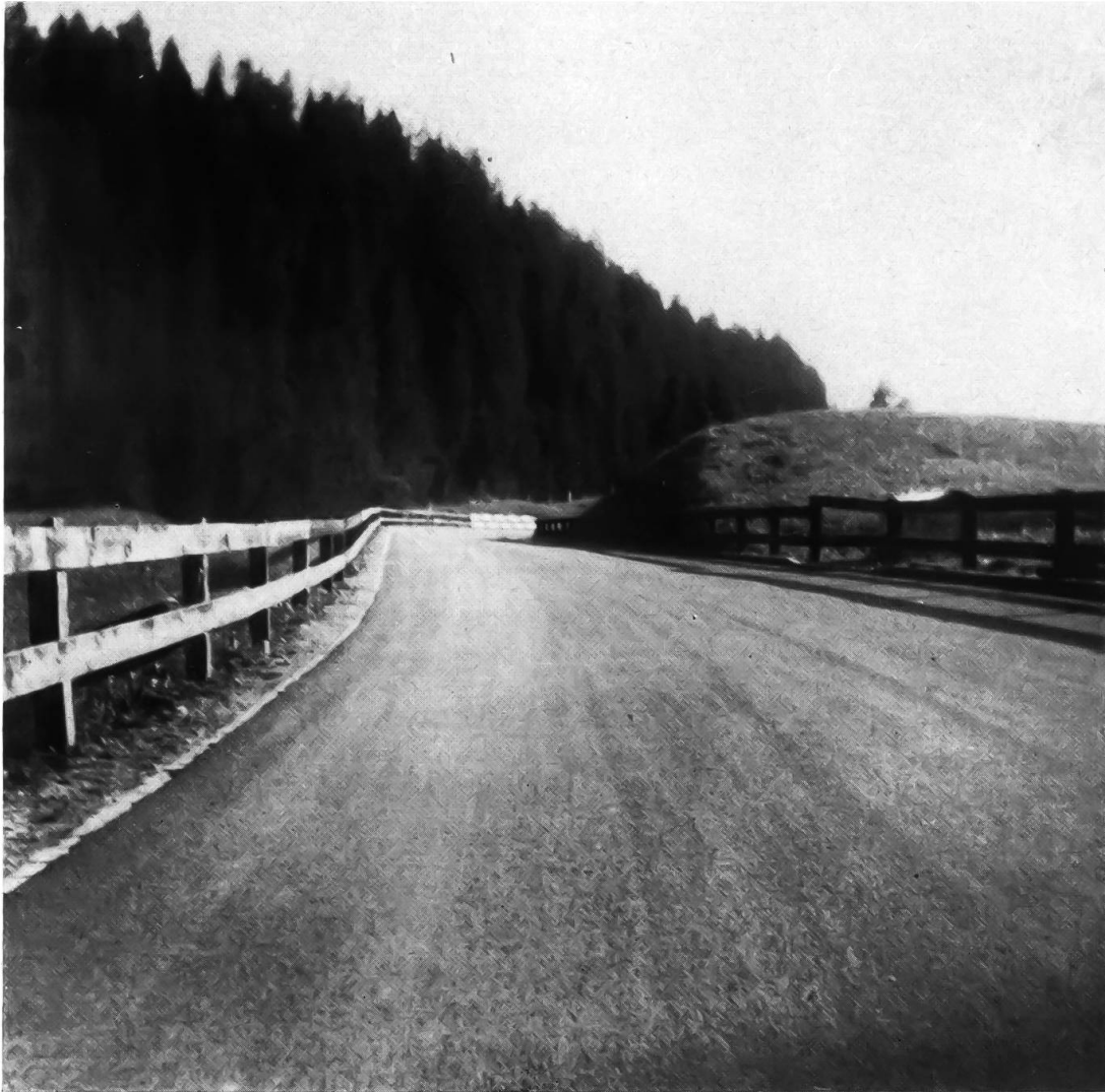
Lehm-Mannried im Simmental - Alphastic-Rauhbelag (Colas AG.) Ausgeführt von der Strassenbauunternehmung M. F. Roth, Bern
