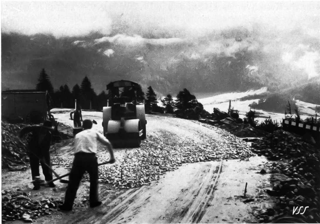
Herstellung der Planie der Strasse
