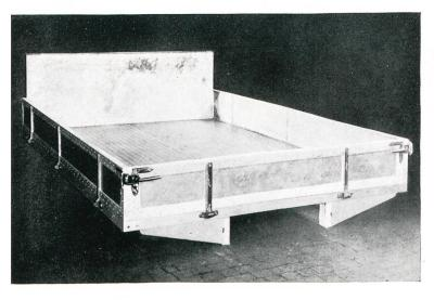
Abb. 6 Leichtmetallbrücke mit Anticorodal-Warzenblech
