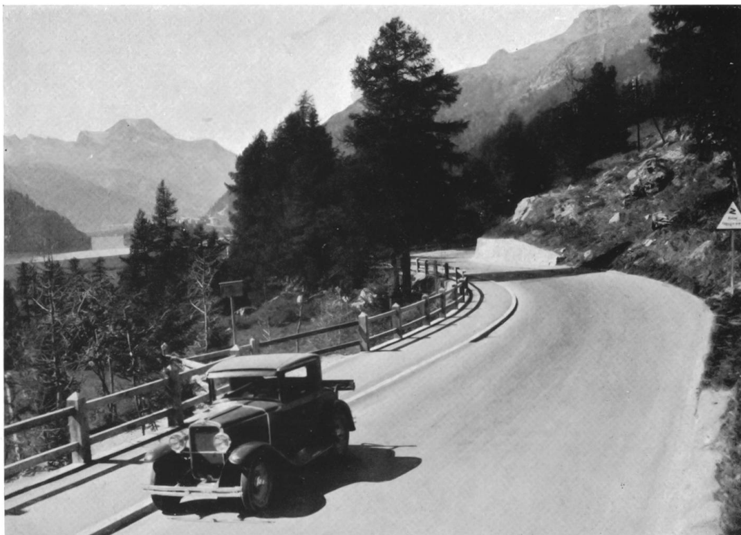
Von der Stuaug ausgebaute Strasse auf 1800 m Meereshöhe (Kurve zwischen St. Moritz und Suvretta House).
