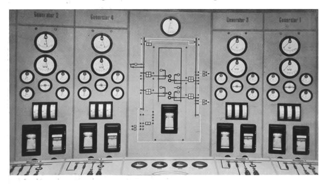
Die Fernsteuer-Apparaturen der AEG ermöglichen die Fernsteuerung von Oel- und Trennschaltern, Reguliertransformatoren, Wasserschiebern usw., sowie deren automatische Stellungsrückmeldung über alle vorkommenden Entfernungen. Die Uebertragung beliebig vieler Kommandos kann über einen Verbindungskanal, also über ein Aderpaar, eine unterlagernde Mittelfrequenz oder eine Hochfrequenzträgerwelle erfolgen.
