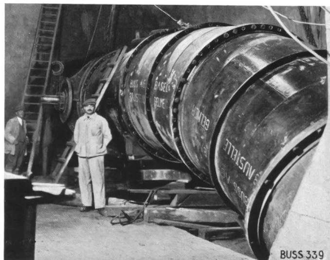
Apparatekammer des Druckschachtes Gelmersee-Handeck.
