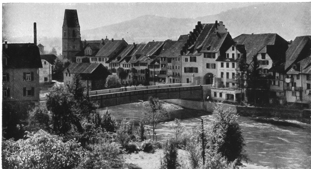
Eiserne Strassenbrücke über die Reuss bei Mellingen
