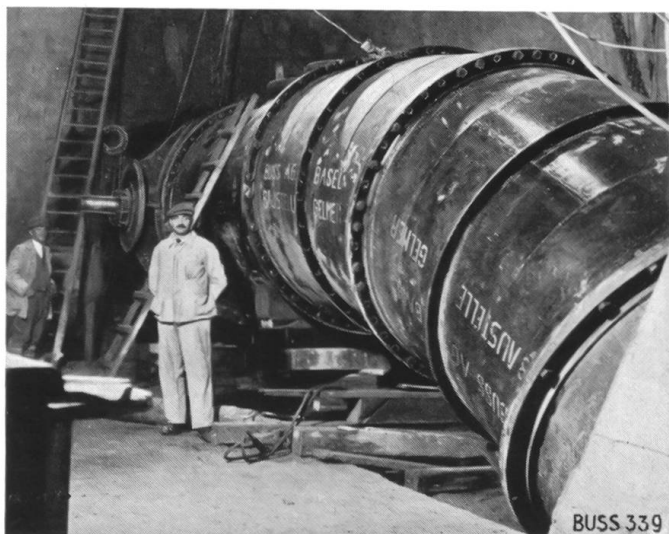
Apparatechamber des Druckschachtes Gelmersee-Handeck.
