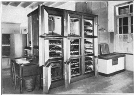
Spezial-Kühlschrank mit Glacé-Konservator im Kursaal Interlaken.
