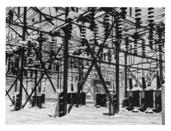
Freiluftstation 50,000/150,000 Volt des Kraftwerkes Oberhasli in Innertkirchen. Mit Langenthaler Isolatoren ausgerüstet.
