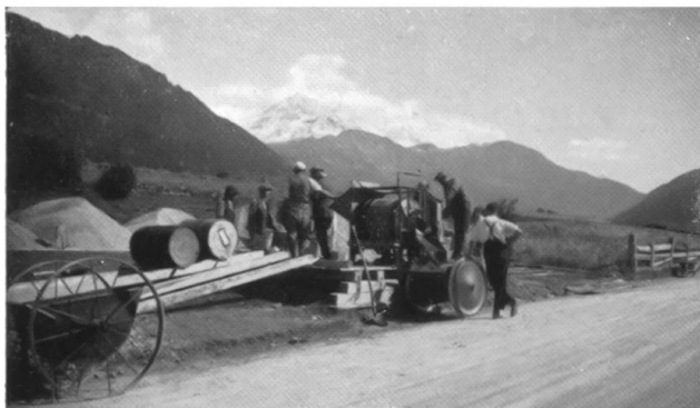
Einbau eines Colzuma-Mischbelages auf der Julierstrasse.
