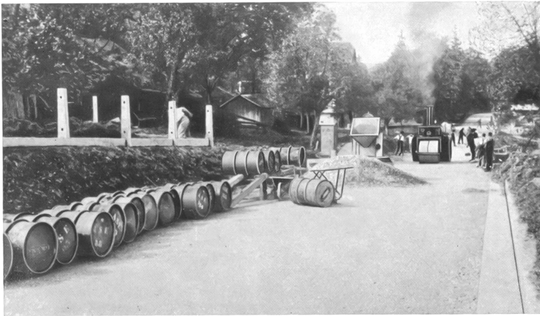
Baustelle eines Colzuma-Kaltmischbelages.
