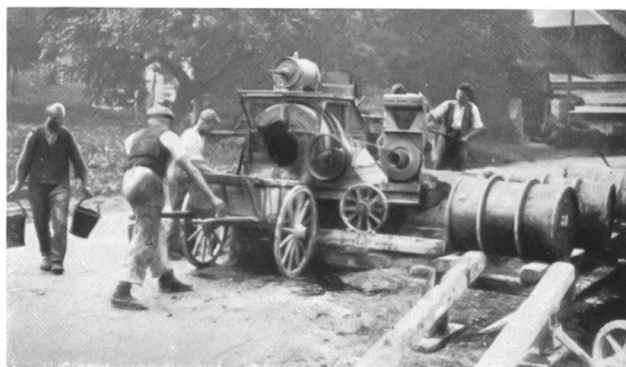
Mischgut-Präparation auf der Baustelle.
