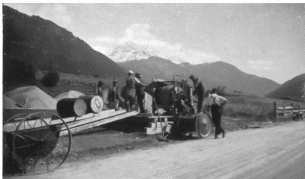
Einbau eines Colzuma-Mischbelages auf der Julierstrasse.
