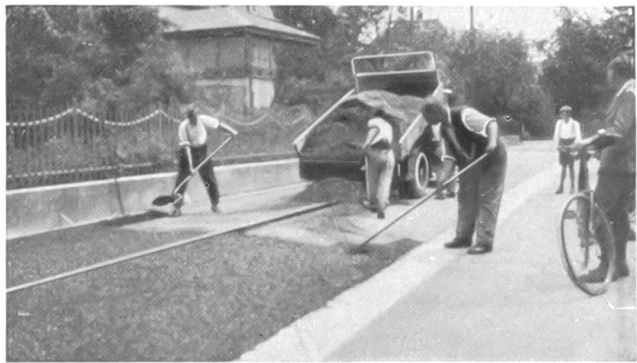
Einbau des Mischgutes.
