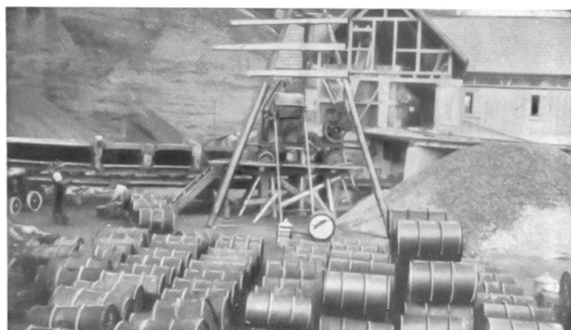
Mischgut-Präparation in einem Steinbruch.
