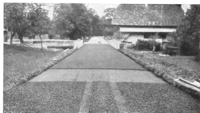
Zweischichtiger Belag beim Einbau.
