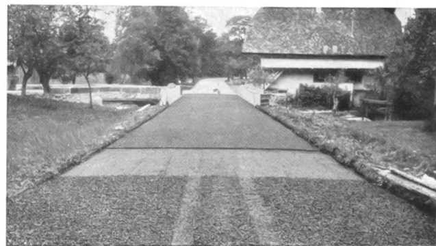
Zweischichtiger Belag beim Einbau.
