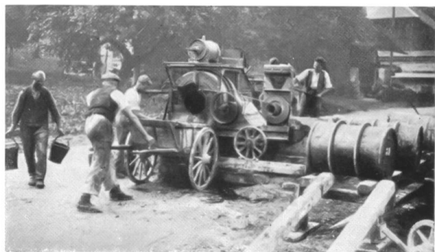
Mischgut-Präparation auf der Baustelle.
