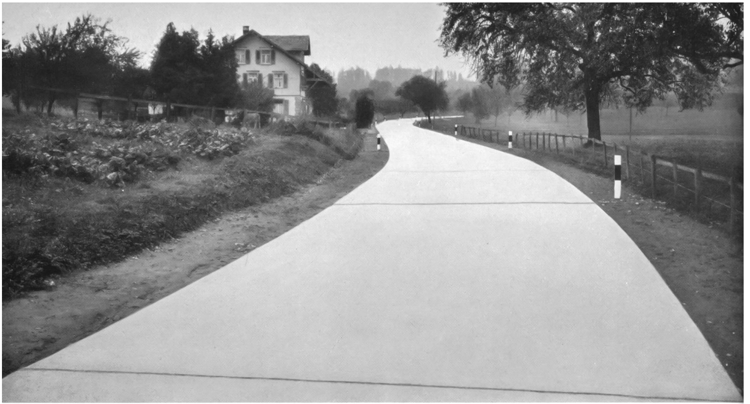
Betonstrasse bei Bischofszell, Kt. Thurgau
