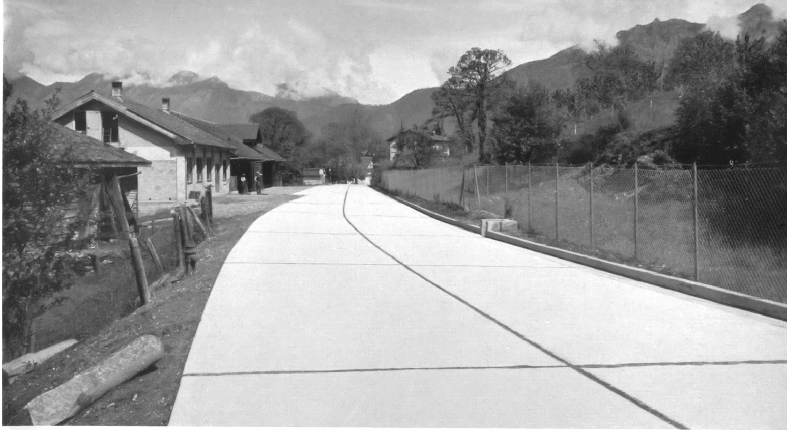
Betonstrasse auf Monte Ceneri, Tessin
