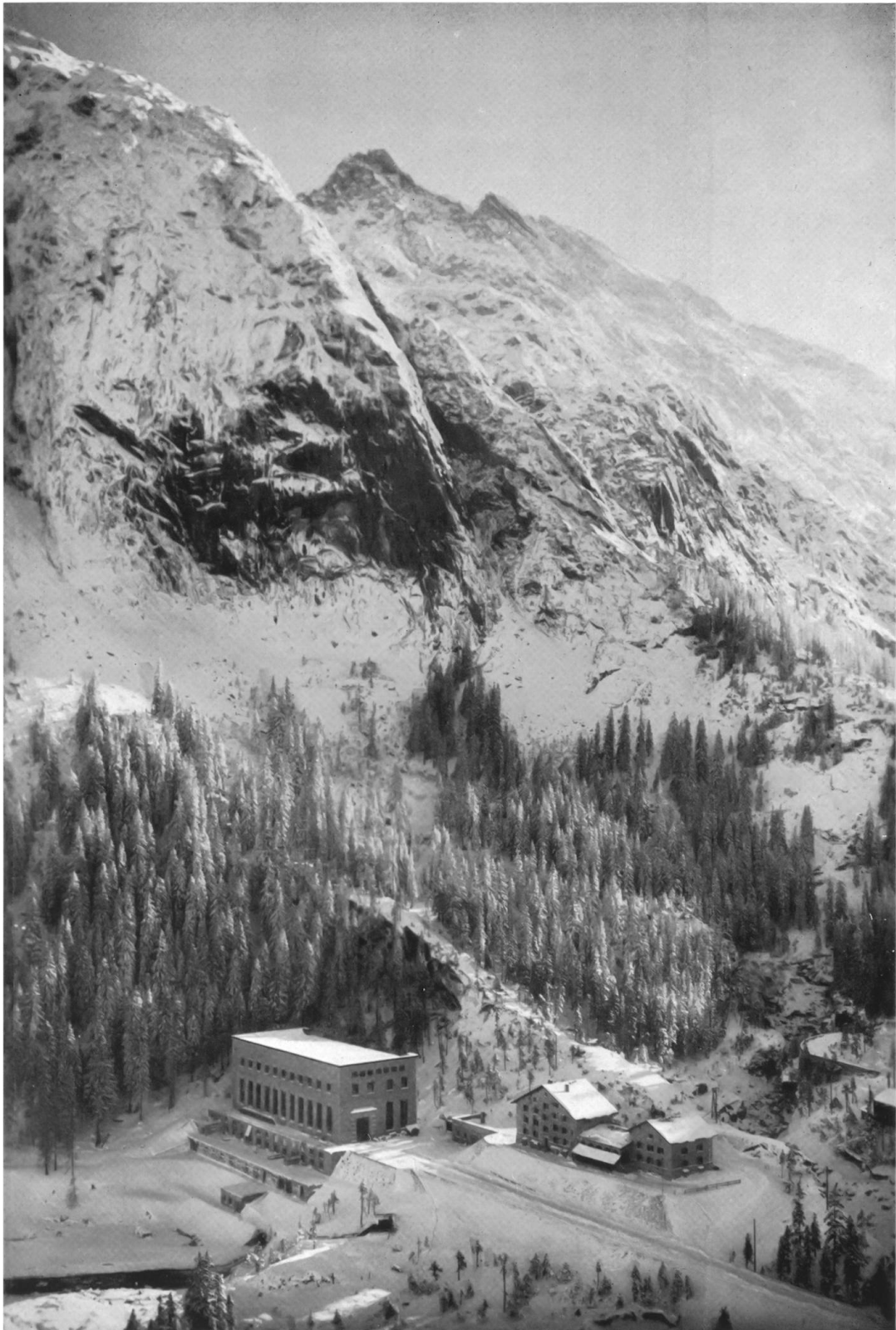
Zentrale Handeck und Maschinistenhäuser.
