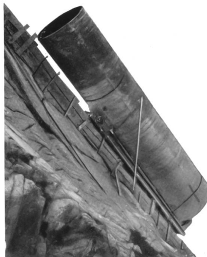
Rohrtransport auf der Standseilbahn. 106% Steigung.
