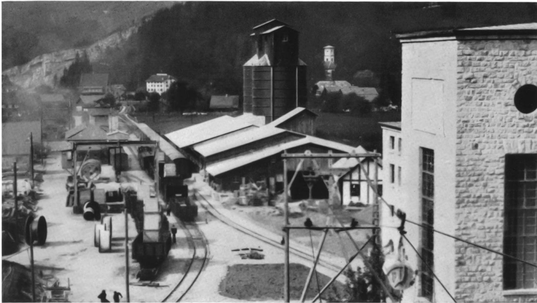
Bahnstation Innertkirchen mit Zementsilos und Beginn der Luftkabelbahn.
