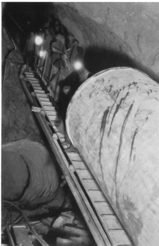
Ablassen eines 9 t schweren und 230 cm weiten Rohres im Druckstollen.
