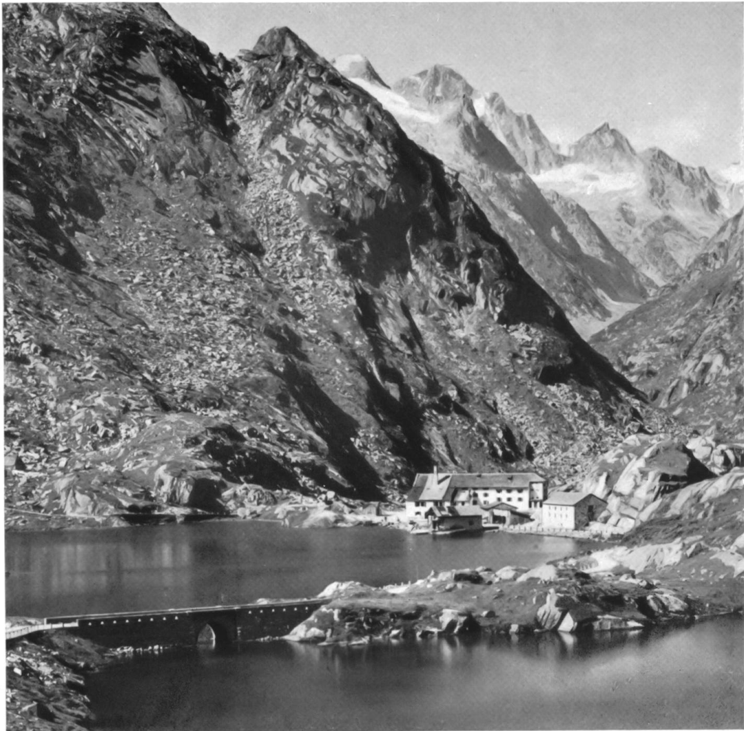
Das alte Hospiz vor der Ueberflutung im September 1929.
