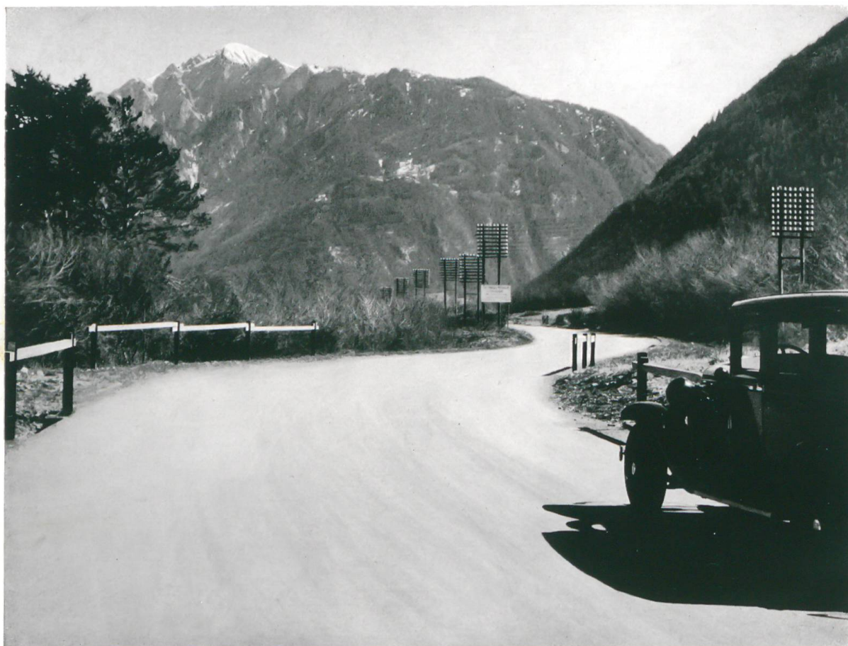
STRASSE CHUR-EMS, HALBTRÄNKUNG MIT KALTASPHALT UND OBERFLÄCHENBEHANDLUNG MIT SPRAMEX
