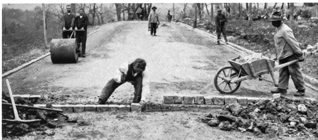
Erstellen der Planie für Kurvenpflasterung auf der Hauensteinstrasse.
