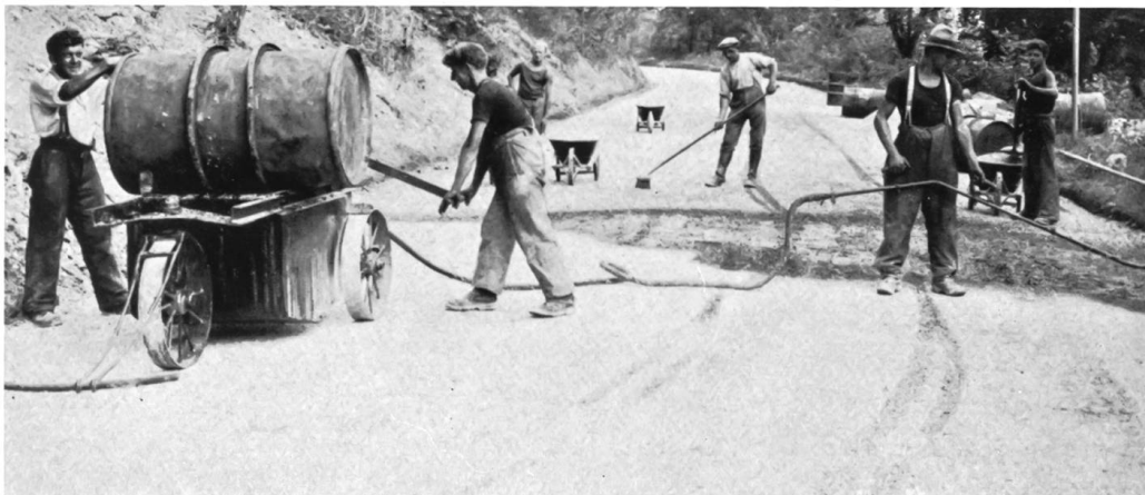
Bitumulstränkung auf der Hauensteinstrasse.
