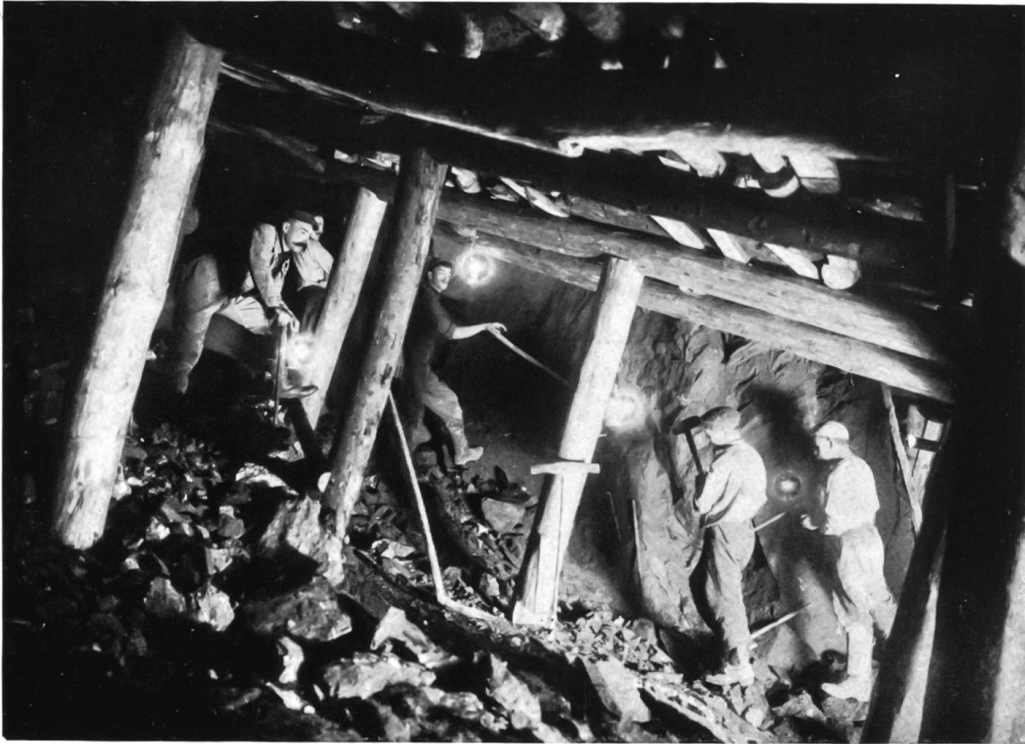
Asphaltmine im Traverstal.
