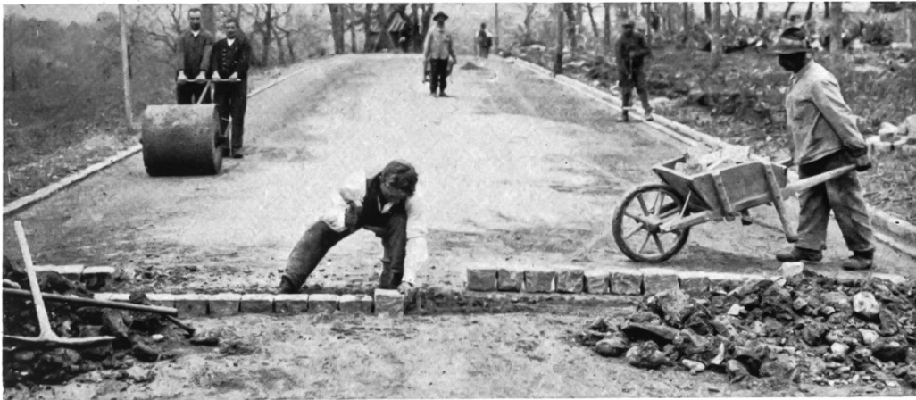
Erstellen der Planie für Kurvenpflasterung auf der Hauensteinstrasse.
