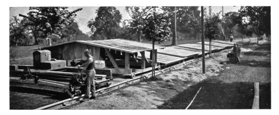
Von der als Automobil fahrbaren Betoniermaschine wird der Beton auf einem Band zur Verwendungsstelle gebracht. Fahrbare Schutzdächer 3 halten Witterungseinflüsse vom frischen Beton ab und während 14 Tagen kommt auf die fertige Strasse eine 5 cm hohe Sandschicht, die, um ein zu rasches Trocknen der Betonmassen zu verhindern, mit Wasser besprengt wird.
