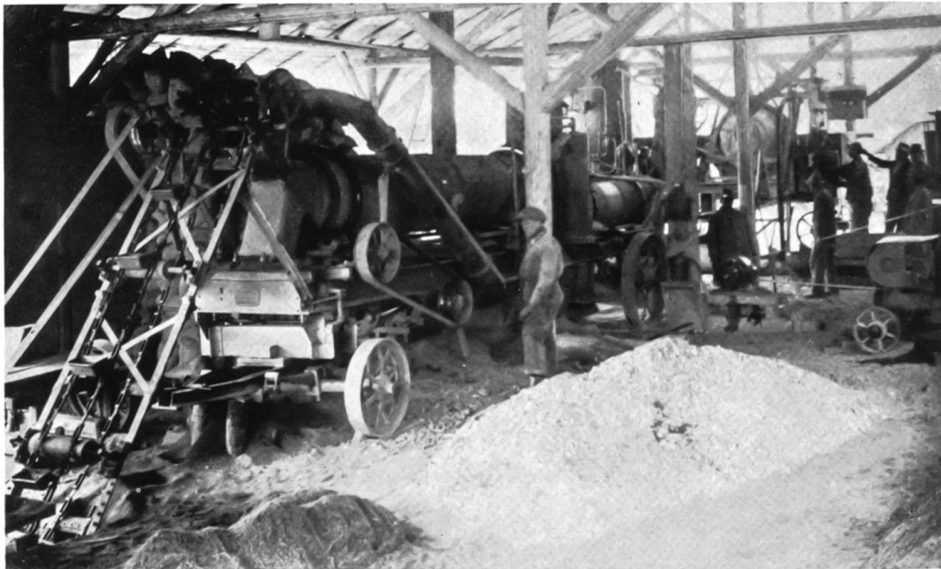
Präparations-Installation für einen Bitumhartbelag.
