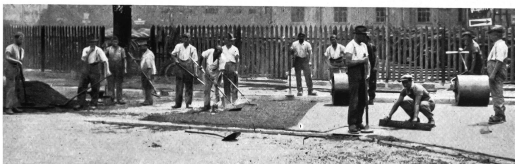
Erstellen eines Sandasphaltbelages auf der Gösenstrasse in Olten.
