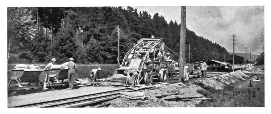
Nachdem die Unterschicht des Strassenbelages mit Pressluftstampfern gedichtet ist, erfolgt die Bearbeitung des Oberbetons mittelst einer Spezialmaschine, dem Strassenfertiger ①, welche den Beton profilgerecht abzieht, ihn stampft und glättet.
