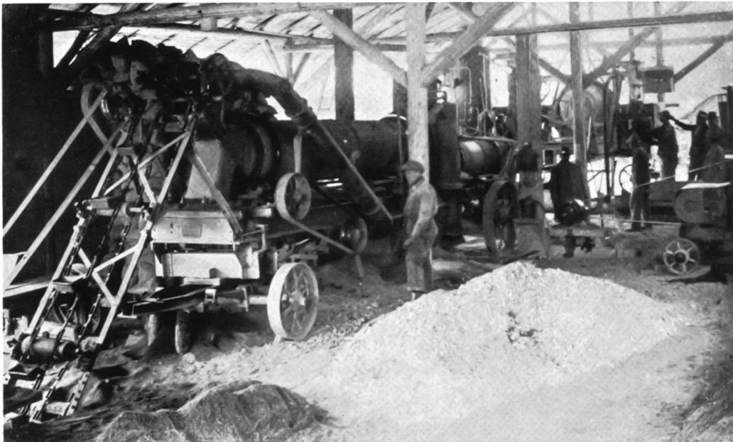
Präparations-Installation für einen Bitumhartbelag.
