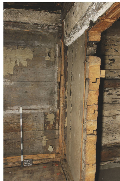
3 Abbildung: Bei der Bauuntersuchung kamen die Bohlen eines spätmittelalterlichen Ständerbohlenbaus zum Vorschein. © KA ZH, Christoph Héglé.
