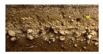
Die mehrteilig aufgebaute Römerstrasse im Profil.
