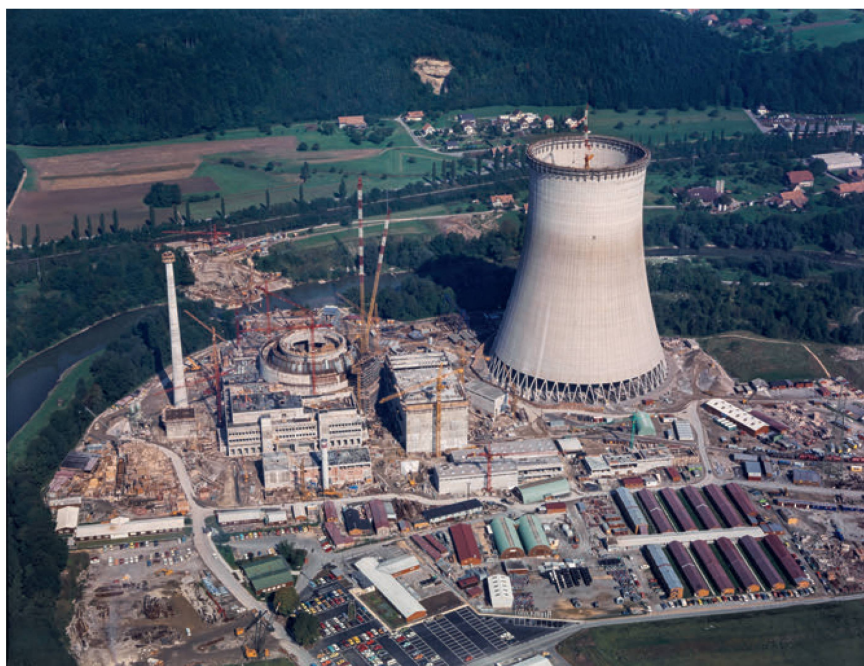
4 Ruinen einer nahen Zukunft? Bau des Atomkraftwerkes Gösgen-Dänikon, 1975.
