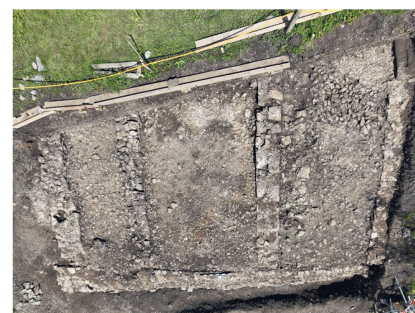
3 Grundmauern eines Terrassenhauses im Augster «Wildental». © Römerstadt Augusta Raurica.
