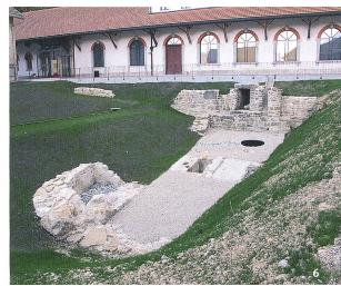
Fig. 5 Vue des maçonneries dégagées au pied de la façade. Au premier plan, les vestiges extérieurs de la galerie ayant remplacé l'exutoire primitif. En arrière-plan, les murs de la digue primitive.
