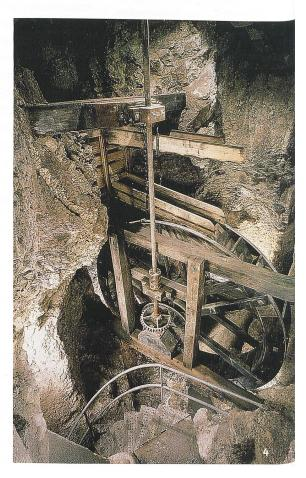
Fig. 4 Roue à augets installée à l'intérieur de la grotte, dans le puits n°2, depuis
