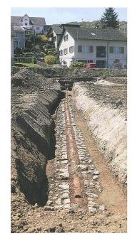
wasserführende Kanal ist mit vermörtelten Hohlziegeln abgedeckt. Partiell ist eine schützende Kieselmörtellage über den Hohlziegeln nachzuweisen. Auffällig ist, dass in viele der Deckziegel bereits während der Nutzungszeit grössere Löcher geschrotet worden sind; sie könnten als Indizien für notwendig gewordene Unterhaltsarbeiten etwa nach Einsickerung von Sedimenten - gedeutet werden.
