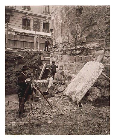
Fig. 2 Vue des fondations de la Tour de l'Ile, dégagées en 1898.
