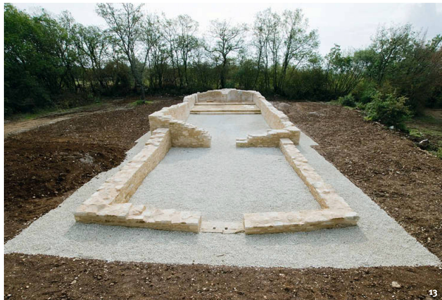
Fig. 13 L'église Sainte-Cécile au terme du chantier de restauration. Il ne manque que la patine du temps, qui atténuera l'impact sur le paysage actuel.
