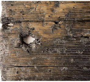
Abb. 4 Detail einer Dachschindel mit Durchlochung.
