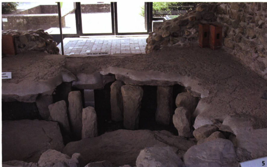
Abb. 5 Die Pfeiler der Hypokaustheizung konnten aus Ziegeln oder (wie hier im Gutshof von Sargans SG) aus monolithischen Steinen bestehen. An der Wand sind einzelne für den Luftdurchzug nötige Hohlziegel ( tubuli ) zu sehen.
