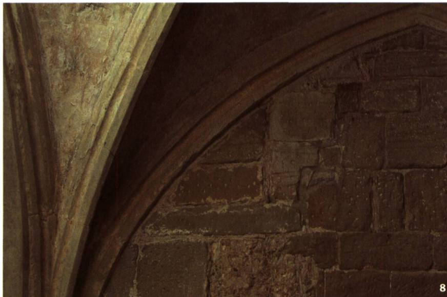
Abb. 8 Die Reste eines Zugangs zum Schlafraum der Konversen. Diese Türe wurde im 13. Jahrhundert wahrscheinlich im bestehenden romanischen Mauerwerk neu geschaffen, und im Zuge der Errichtung des überwölbten gotischen Kreuzgangs wieder aufgegeben.
