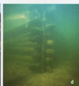
temps, il fallut enfoncer le cadre et les plaques d'angle sous la surface de l'eau, de manière à ce que la couche suivante puisse être mise en place. On procéda ainsi niveau après niveau, les troncs s'enfonçant toujours plus profondément, jusqu'à ce que les perches passées au travers des plaques d'angle soient solidement ancrées dans le fond du lac. Enfin, on mit en place un plancher, avant de déverser près de deux tonnes de gravier sur cette construction et d'en vérifier la solidité.
