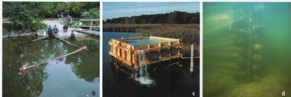
temps, il fallut enfoncer le cadre et les plaques d'angle sous la surface de l'eau, de manière à ce que la couche suivante puisse être mise en place. On procéda ainsi niveau après niveau, les troncs s'enfonçant toujours plus profondément, jusqu'à ce que les perches passées au travers des plaques d'angle soient solidement ancrées dans le fond du lac. Enfin, on mit en place un plancher, avant de déverser près de deux tonnes de gravier sur cette construction et d'en vérifier la solidité.
