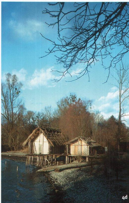
Même après avoir subi plusieurs orages estivaux et des tempêtes avec des vents de force 10, la toiture a bien résisté et est restée étanche. Les quelques emplacements laissant filtrer l'eau de pluie ont été colmatés avec des déchets de bois issus de la confection des planches. Pour le débitage des bois et la construction de la maison, les ouvriers ont utilisé des outils modernes. Pour les liens, on a eu recours à de la corde de chanvre de
